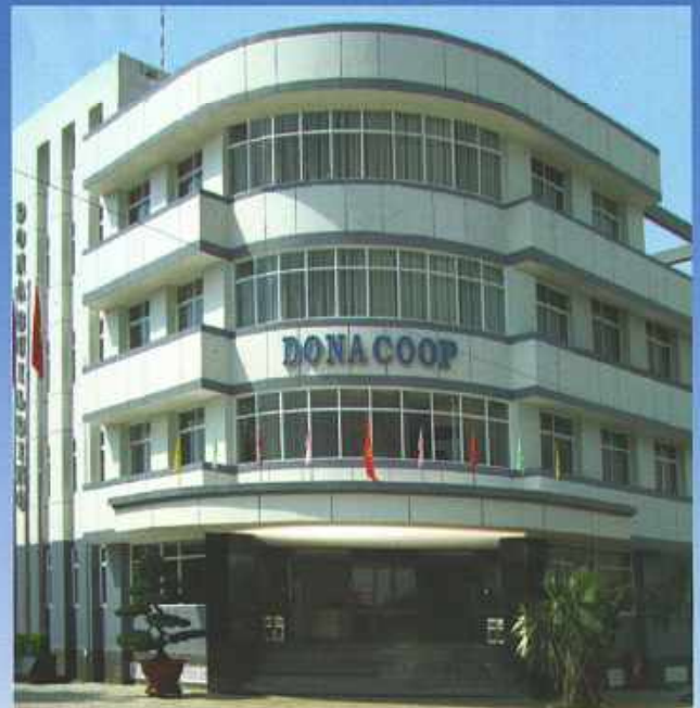
Tên Công Trình: VĂN PHÒNG DONACOOP Địa Chỉ: Biên Hòa - Đồng Nai
